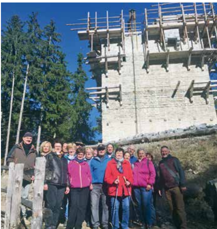
Der Burgbau zu Friesach wurde begutachtet
