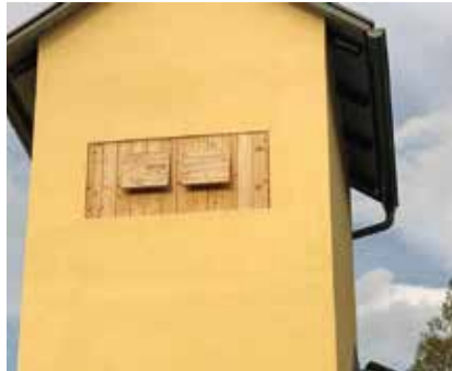
Einflugschlitze für Fledermäuse beim Pumphäuschen
