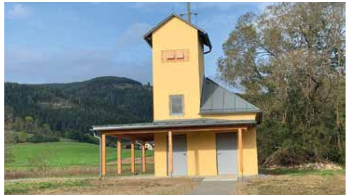
Gesamtansicht Pumphäuschen mit Vordach
