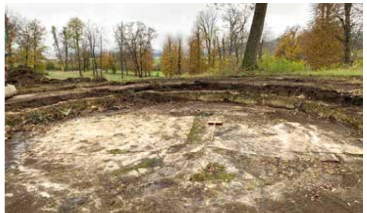
Das gereinigte Betonbecken als Zentrum des Naturbiotops
