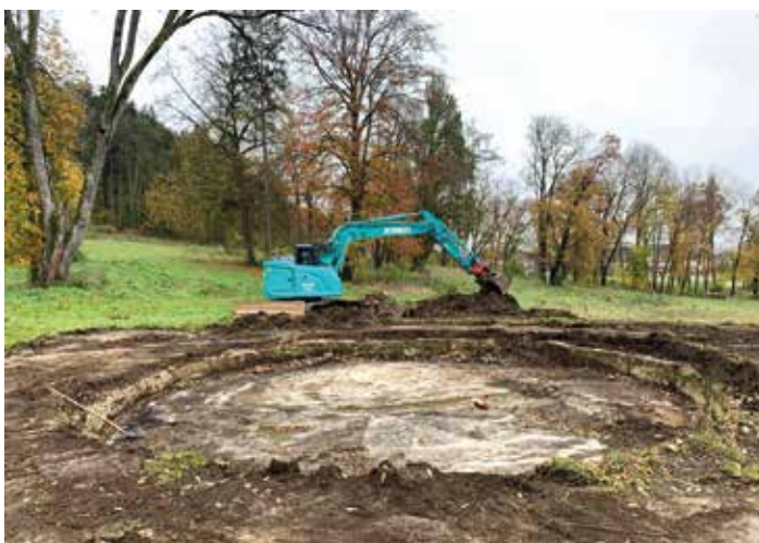
Ausräumung Betonbecken
