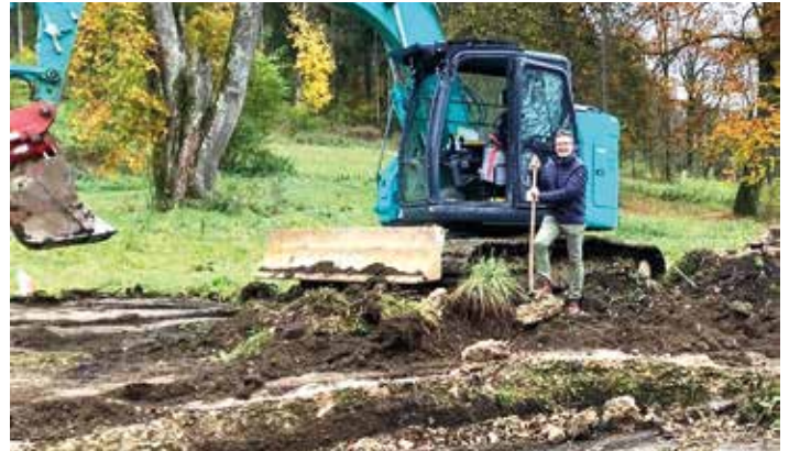
Spatenstich Naturbiotop durch STR Wolfgang Leitner
