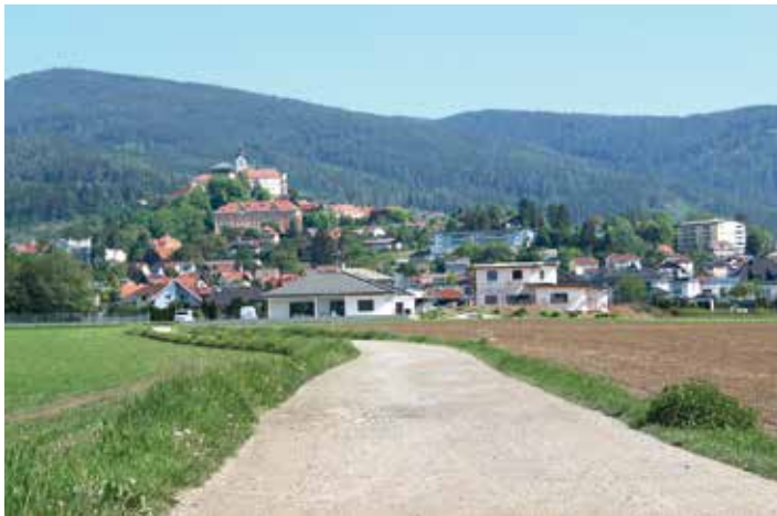
Am Bild Toniackerl: In der neuen Rudolf-Printschitz-Straße werden Einfamilienhäuser gebaut.
