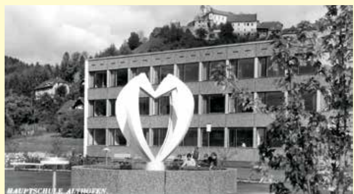
Das neue Hauptschulgebäude mit dem Brunnen davor
