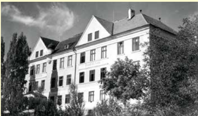
Die alte Hauptschule als Zubau an die Volksschule
